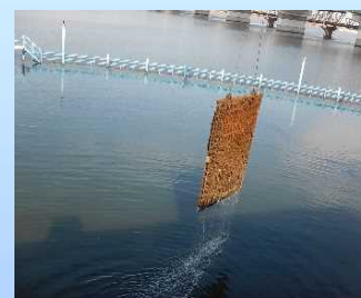
止水作業(スクリーン撤去)
