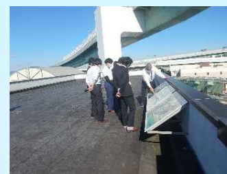
概要説明(屋上)
