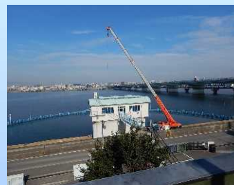
止水作業(クレーン配置)
