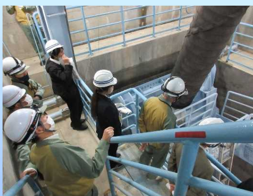
常用洪水吐きでの状況
