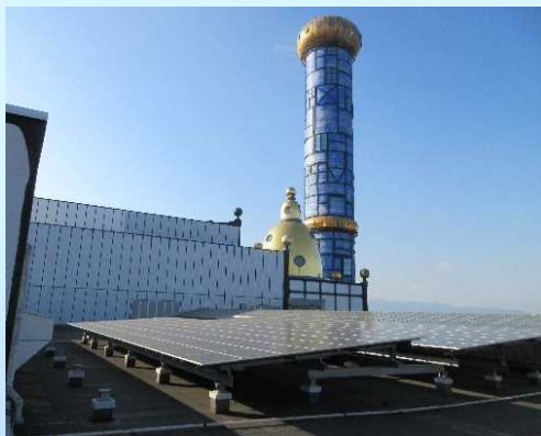
舞洲スラッジセンターの外観状況
