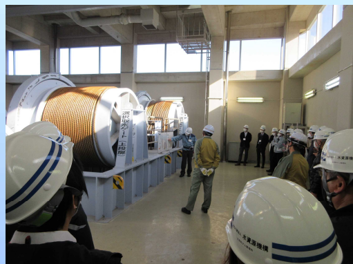
取水ゲート室での状況
