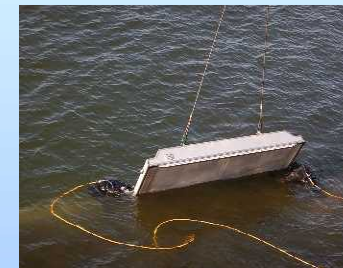
止水作業(角落とし設置)
